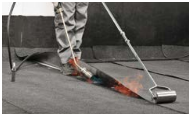
Рис. 3.46. Сварка шва с использованием газовой горелки
