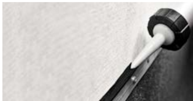
Рис. 3.24. Герметизация края краевой рейки
