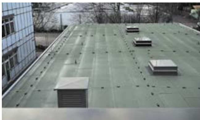
Рис. 3.56. Устройство молниеприемной сетки на кровле
