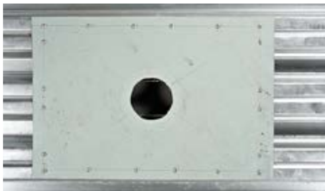
Рис. 3.4. Лист усиления в месте прохода через профилированный лист водоприемной воронки
