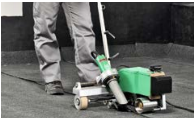
Рис. 3.45. Сварка шва автоматическим оборудованием
