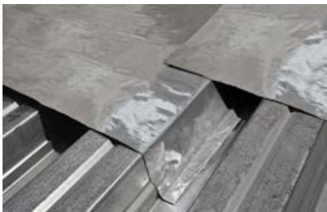
Рис. 3.6. Формирование продольного нахлеста пароизоляции на профлисте
