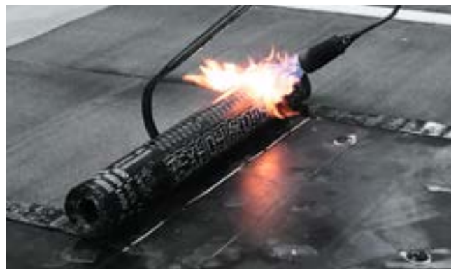
Рис. К.1. Наплавление по теплоизоляционным плитам
