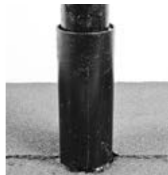
Рис. 3.33. Примыкание кровли к трубе
