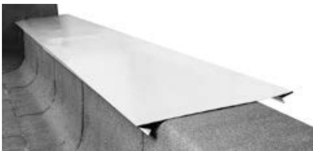
Рис. 3.29. Установка парапетной крышки
