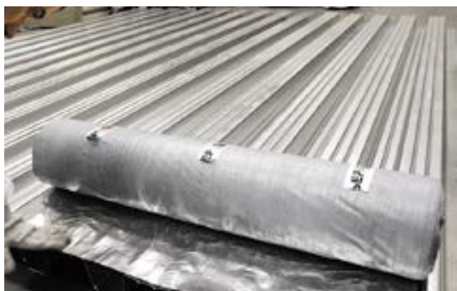
Рис. 3.5. Укладка пароизоляционного материала по профлисту
