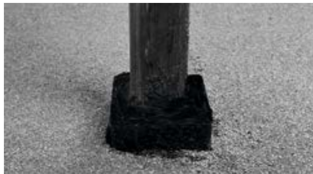
Рис. 3.37. Примыкание кровли к трубам малого диаметра
