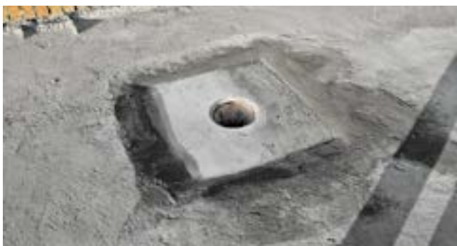
Рис. 3.12. Локальное понижение в месте установки воронки
