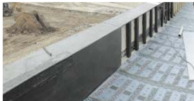
Рис. 3.15.б. Обшивка хризотилцементными плоскими листами (цементно-стружечными плитами марки ЦСП-1) вертикальной поверхности
