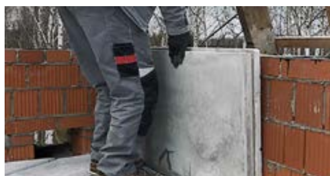
Рис. 3.15.а. Обшивка сэндвич-панелями ТЕХНОНИКОЛЬ Ц-ХПС CARBON вертикальной поверхности
