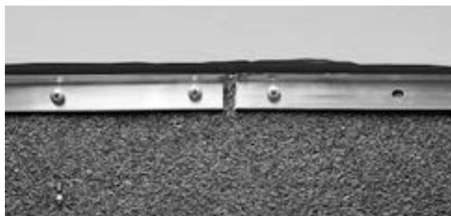
Рис. 3.21. Зазор между краевыми рейками
